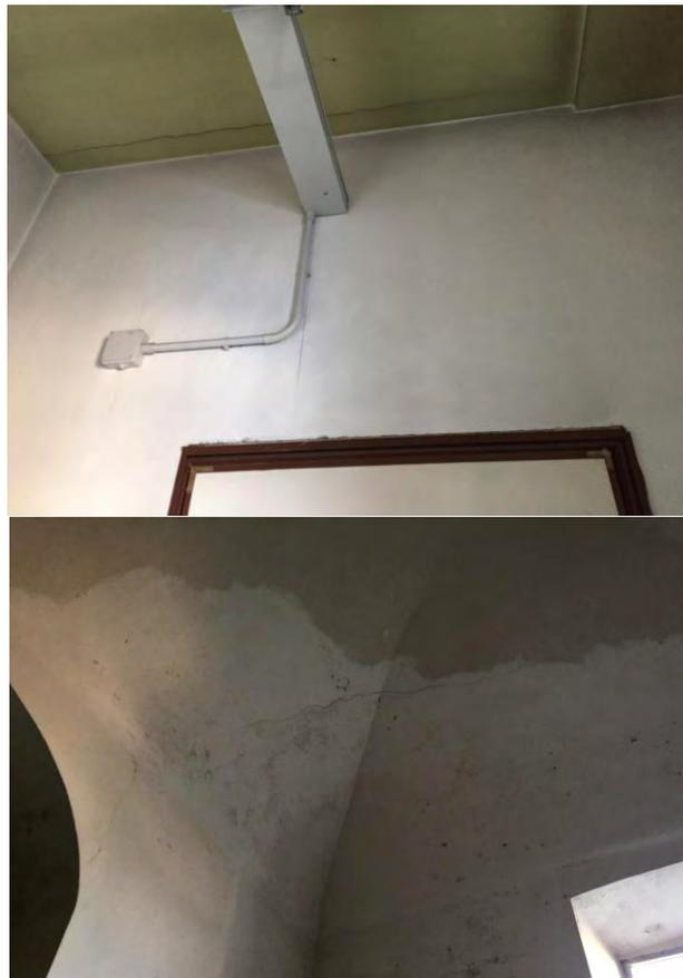
**Figura 5.29:** Lesione sul corridoio(sopra) e nell'aula ripostiglio (sotto) del secondo piano
