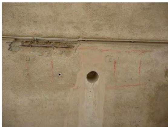
**Figura 8.19:** rilievo pacometrico dell'armatura di una trave di bordo, finalizzato ad individuare zone libere da armature per l'esecuzione di carotaggio
