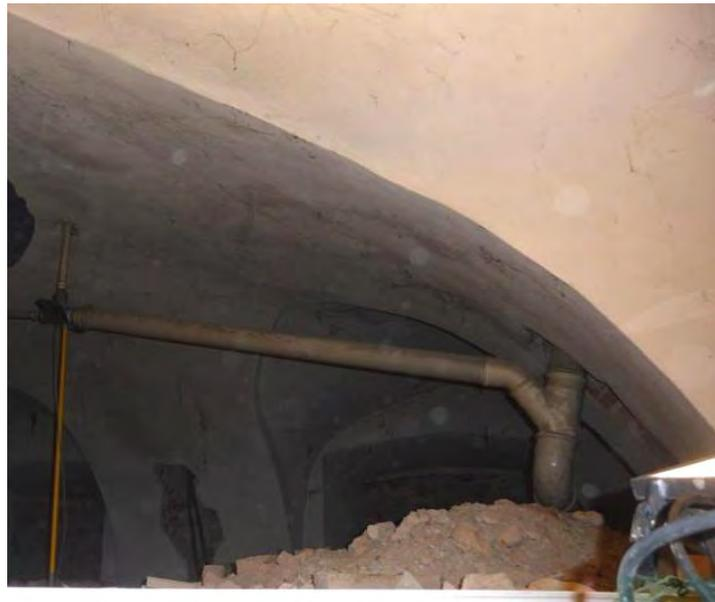
**Figura 7.9:** Volte strutturali ancora visibili dalla botola di accesso
