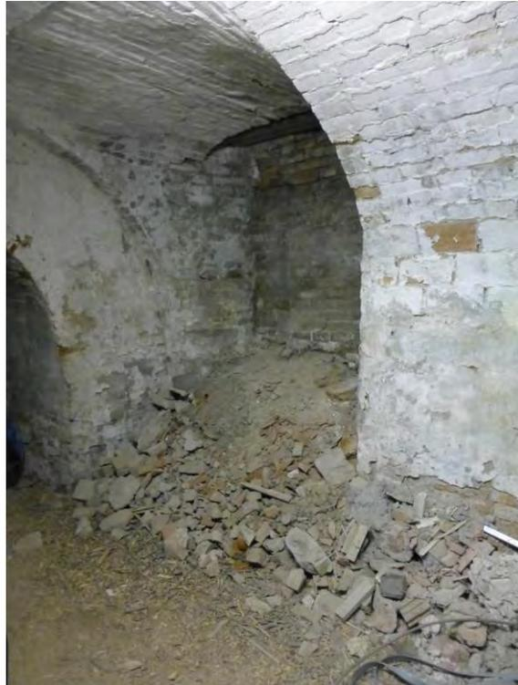
**Figura 5.2:** parziale svuotamento dell'estradosso delle volte durante i lavori di posa degli impianti
