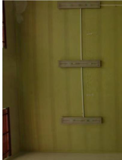
**Figura 5.23:** macchie di umido e piccole fessurazioni
