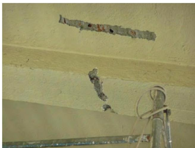
Figura 8.12: scrostamento per il rilievo dell'armatura di una trave centrale della copertura e della soletta.
