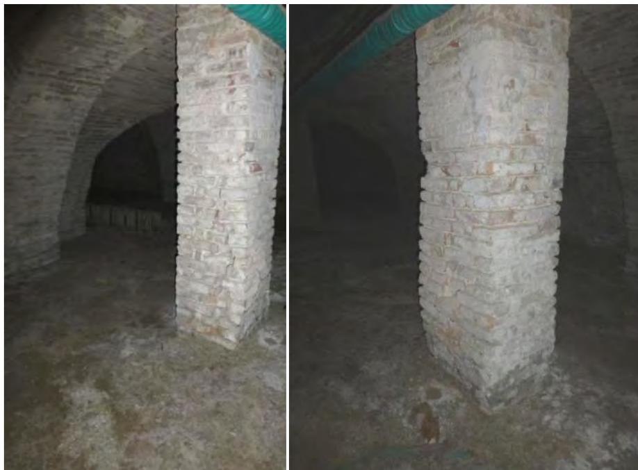
**Figura 3.10:** Lesioni osservate sul pilastro del piano interrato
