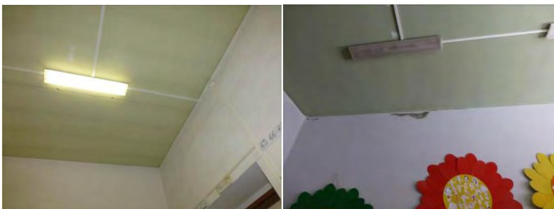
**Figura 3.13:** Lesioni sul controsoffitto (sinistra) e sul collegamento con il muro (destra)
