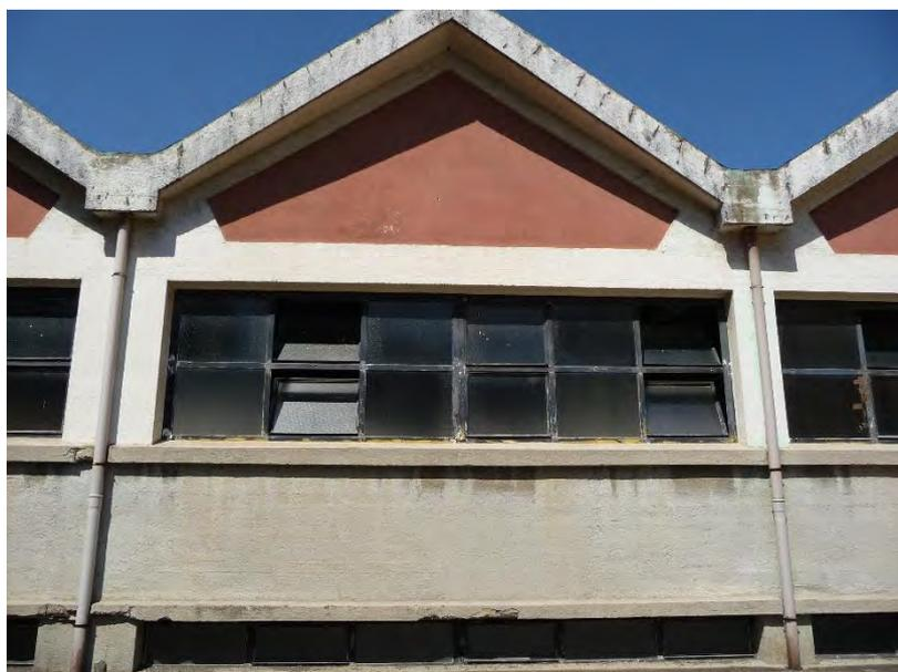
**Figura 8.24:** armatura esposta in elementi non strutturali: sono evidenti le staffe dei cornicioni e le armature longitudinali inferiori dei pannelli di tamponamento in calcestruzzo
