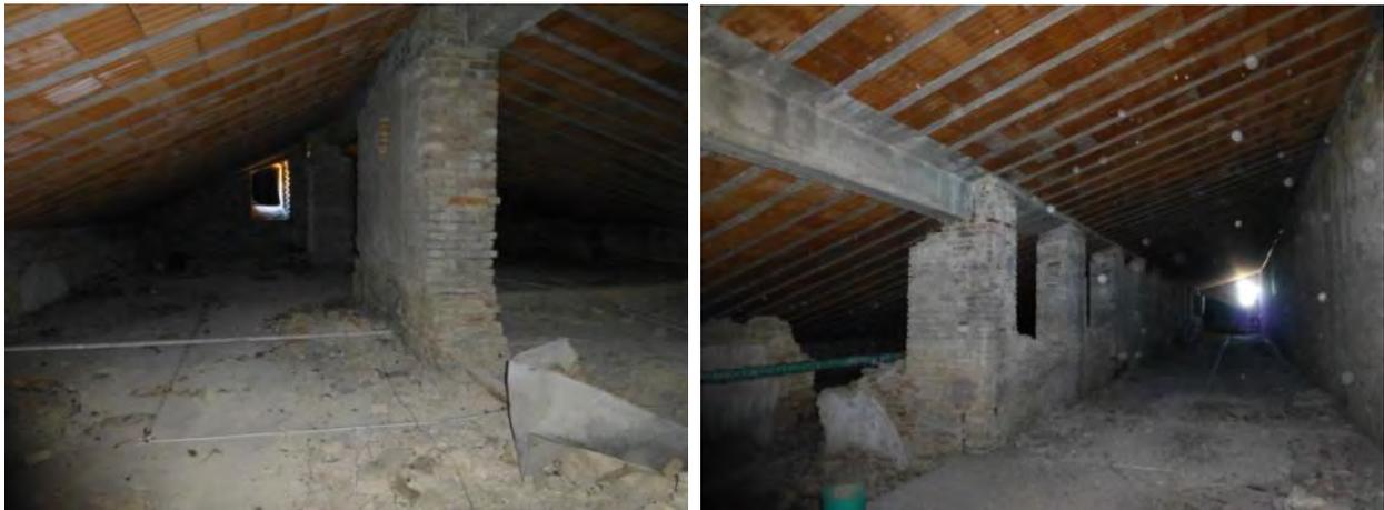
**Figura 5.33:** travi di cemento armato della copertura
