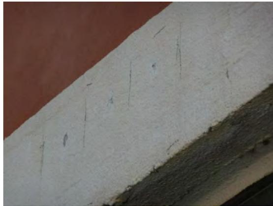
**Figura 8.18:** rilievo pacometrico dell'armatura (staffatura) di una trave di bordo
