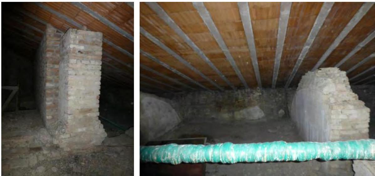
**Figura 5.34:** Pilastrini in muratura inutilizzati
