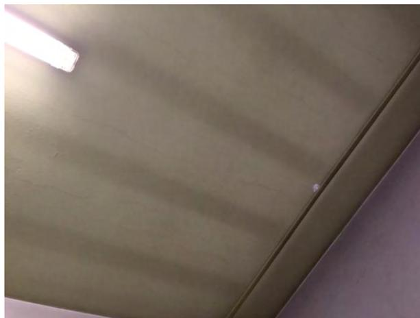
**Figura 5.27:** soffitto piano secondo della "Bandello", si vede chiaramente l'impronta del solaio a travetti
