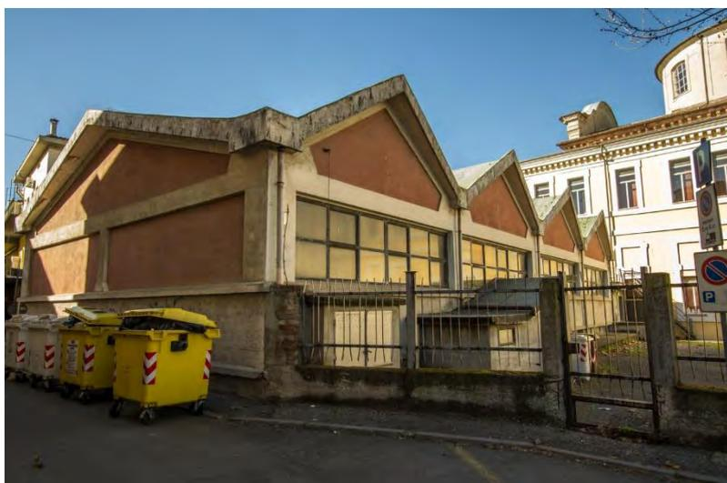
*Figura 8.2: vista esterna della palestra; si rileva la copertura a falde di paraboloidi iperbolico*
