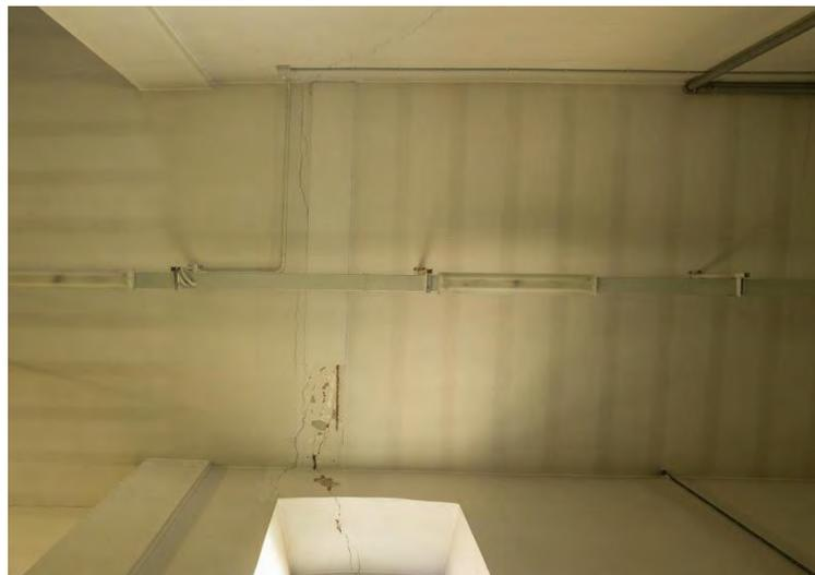
**Figura 5.22:** lesioni sull'architrave indotta dalla presenza della trave in copertura
