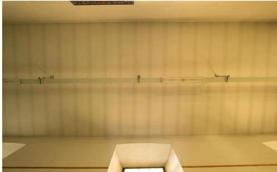
**Figura 5.19:** soffitto della “Bandello”, si vede chiaramente l'impronta del solaio a travetti
