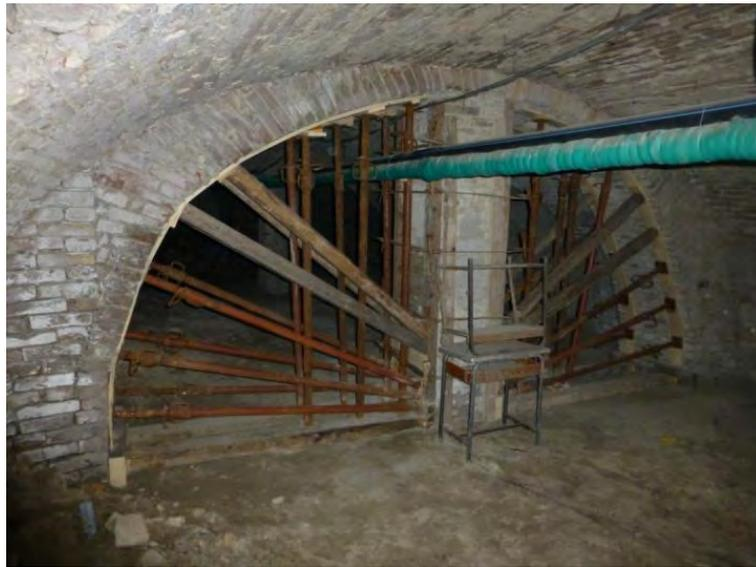
**Figura 3.11:** Intervento di cerchiatura del pilastro del piano interrato (ottobre 2015)
