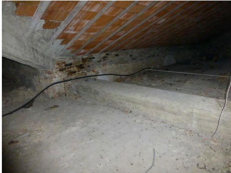
**Figura 5.21:** Una delle travi in calcestruzzo posta nel sottotetto
