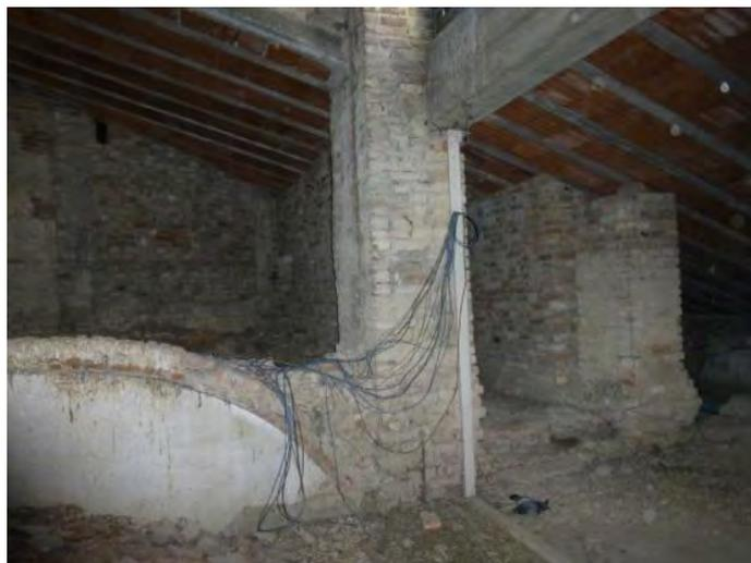
**Figura 5.32:** volta demolita
