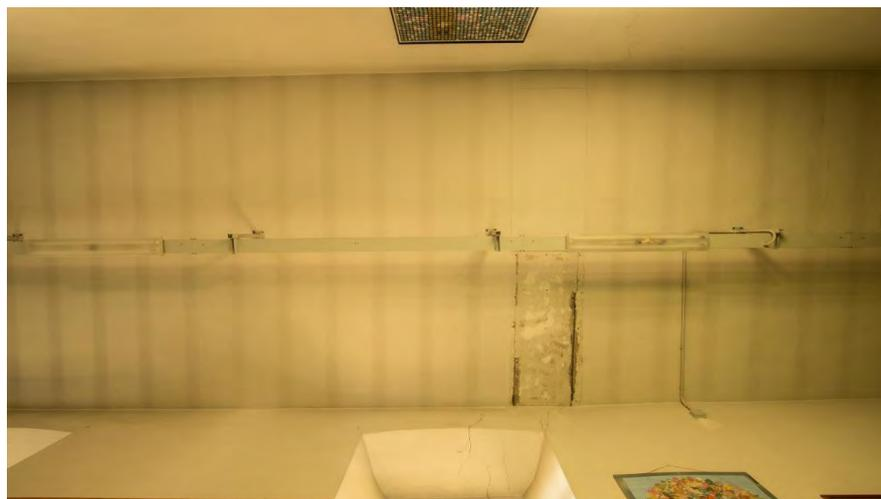
**Figura 5.20:** soffitto della “Bandello”, lesioni riconducibili a carichi anomali in copertura
