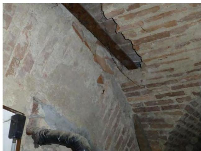
*Figura 3.6: Crenature delle volte dell'interrato*
