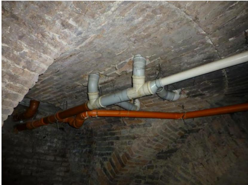
**Figura 5.4:** Tubazione dei servizi igienici installata all'intradosso delle volte
