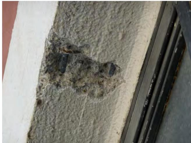
**Figura 8.13:** scrostamento per il rilievo dell'armatura di una trave di bordo.
